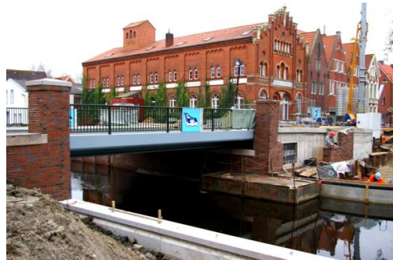
14.11.2012 Einbau der Brücke in die Stahlbetonaufleger
