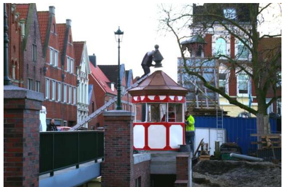
28.11.2012 Aufsetzen des „Rauchabzuges“ auf das grundüberholte Brückenwärterhäuschen; Inbetriebnahme am 21.12.2012
