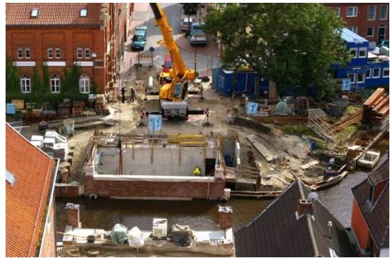
25.9.2012 Stahlbetonaufleger vor Einhängen der Brücke
