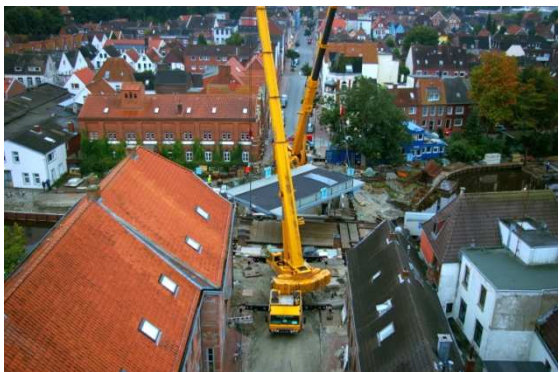
27.9.2012 Zwei Kräne heben und drehen die neue Brücke
