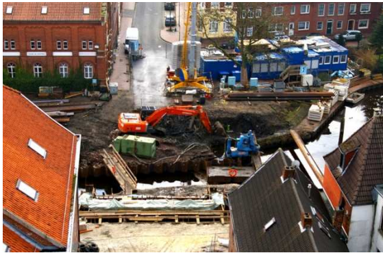
Baugrubenumspundung des Klappenlagers noch am 28.1.2012
