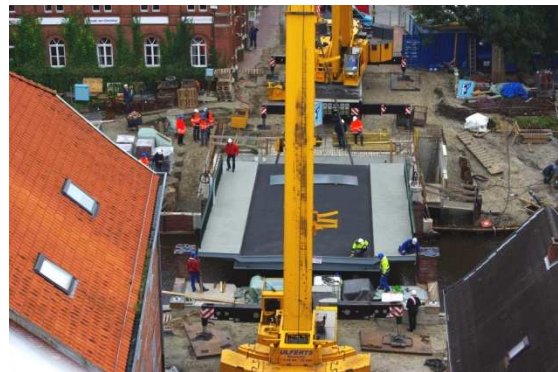
27.9.2012 Einhängen der neuen Rote-Siel-Brücke
