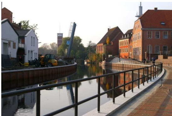
Hochgeklappte Brücke und neue Gehwege an den Ufern des Rote-Siel-Tiefs mit neuen preußischen Kappen
