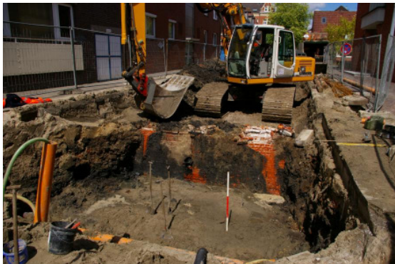
Sanierung „Hof von Holland“, altes Brückenfundament am ehemaligen Brauerspiepentief, 5.5.2010
