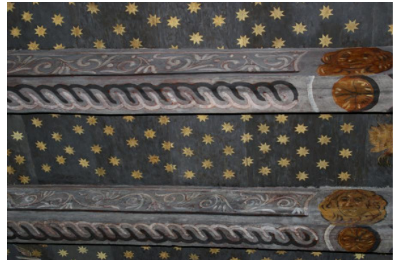
Einzigartige restaurierte Renaissance-Decke im „de Haanschen Haus“ aus dem Jahre 1560
